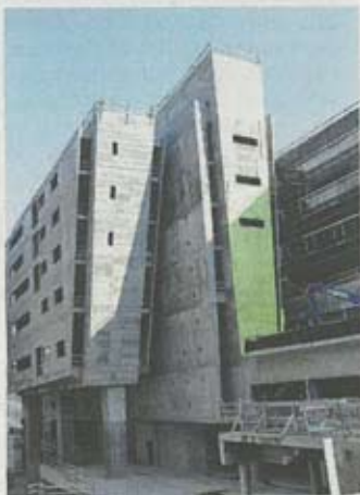
Il cantiere. In corso a Verduno
